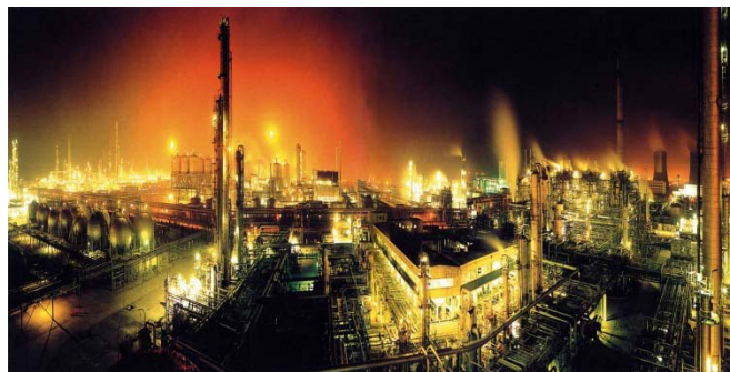
扬子石化30万吨/年乙烯工程
